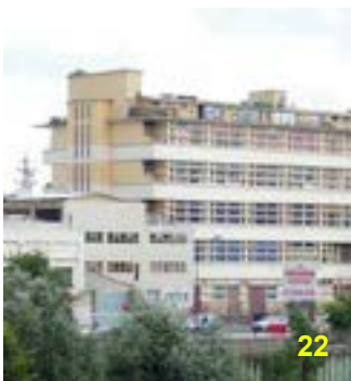
L'écriture horizontale prédominant sur la façade de l'usine Francolor datant de 1949 est reprise au niveau des baies par un jeu de résille
