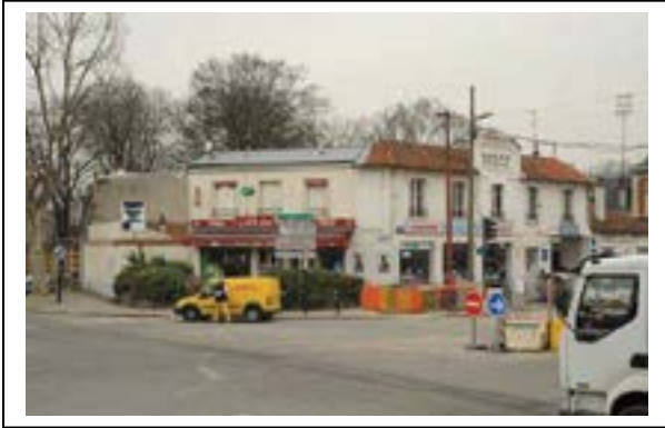
La partie nord-ouest de la place, dont le plan masse est également arrondi, possède des bâtiments bas dédiés aux commerces et activités artisanales, comme c'est le cas sur tout le pourtour de la place (à l'exception de la partie du centre RATP). En effet, cette place « entrée de ville » et lieu de transit devait offrir une halte et des services aux « voyageurs ».
