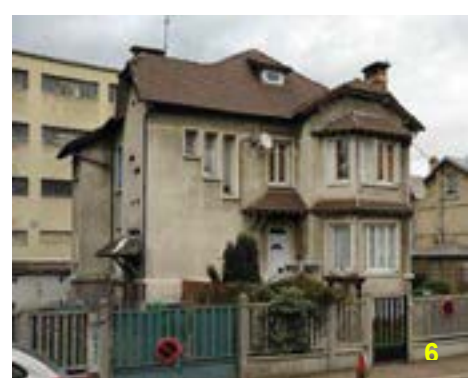
Enduit tyrolien (ou crépi) au 109 avenue du président Wilson
