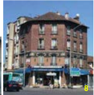
Toit traditionnellement en croupe, à l'angle des rues, ici au 62 boulevard Ornano en tuiles mécaniques
