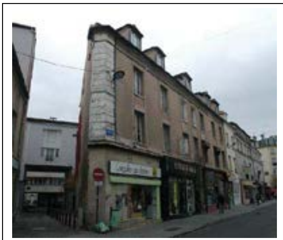
Le croisement entre la rue du Jambon, délimitant le nord de l'îlot et la rue Gabriel Péri : petit pan coupé et refends. Département de la Seine-Saint-Denis, DCPSL, SPC
