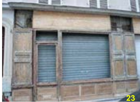
Rue Aubert, exemple d'une ancienne devanture en applique en cours de restauration (23) et restaurée (24). Ce type d'intervention valorise l'immeuble et par extension la façade urbaine de la rue.
