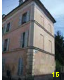
Au 10 rue Emile Conroy l'angle du bâtiment est traité par un pan coupé formant, à rez-de-chaussée, chaîne harpée en pierre de taille.
