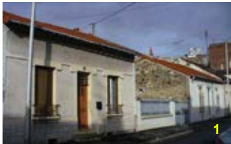
21 – 25 rue d'Arnouville Mur gouttereau sur rue
