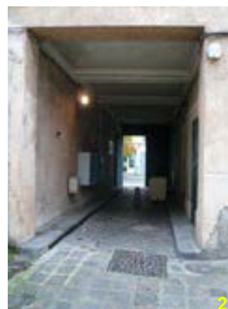
Passage couvert pour accéder à la cour depuis la rue
