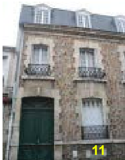
23bis rue Pinel Façade en meulière
