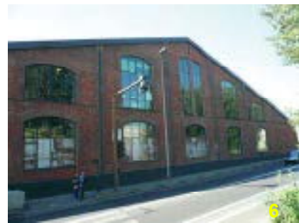
Usine Tréfiméteaux Structure métallique et brique
