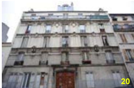
20 5 rue Aubert construit entre 1875 et 1900 Jacques MANGIN – UASD – Département de la Seine-Saint-Denis
