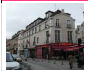
54 rue Gabriel Péri Département de la Seine-Saint-Denis, DCPSL, SPC
