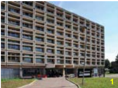
Bâtiment administratif de l'entreprise Alstom Atlantique R. Burgade et P. Rondeau (architectes)
