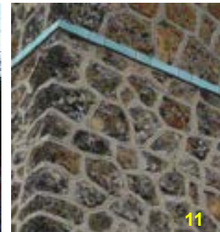
Joints tirés au fer
