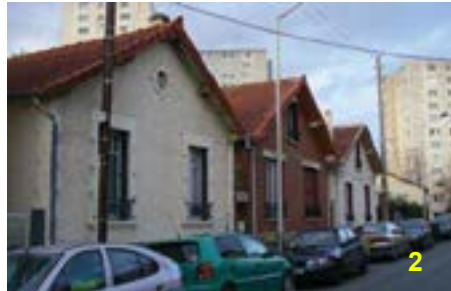
7 - 9 chemin Saint-Léger Mur pignon sur rue
