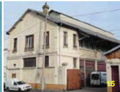
Usine Roche au 21 rue de la Montjoie Ces deux exemples illustrent la mise en œuvre du lanterneau en partie supérieure, au dessus du faitage de la halle. Dans les deux cas, le lanterneau n'est plus utilisé, soit il a été supprimé, soit il a reçu un bardage.
