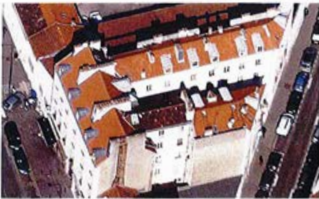
Vue aérienne oblique montrant l'articulation des différents corps de bâtiments et l'implantation des lucarnes et souches de cheminées. A - Octobre 2009 © Habitat 2008
