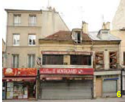
Au 53 rue Gabriel Péri la large corniche est un vestige intéressant de l'architecture de cette époque.
