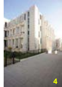
Logements ZAC Basilique R. Simounet (architecte)
