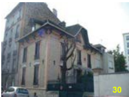
7 rue des Moulins Gémeaux
