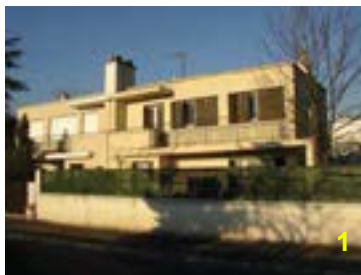
Les pavillons « Lurçat »
