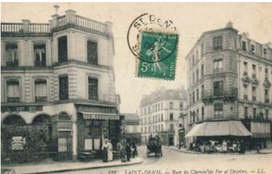
ci-dessus à gauche : le 27 rue Auguste Delaune, ancien café et salle de bal. A l'angle, ce bâtiment est du même gabarit que le 3 rue Dezobry. Ci-dessus à droite : le 1 rue Dezobry avant la disparition de sa modénature et de son décor : les façades formant un tout cohérent avec le reste des bâtiments du carrefour.
