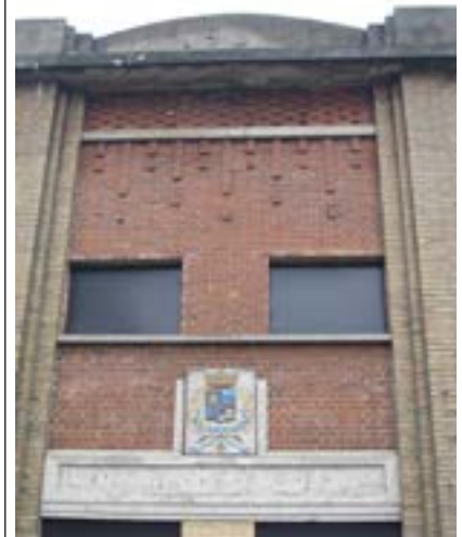
Détail de calepin des bains-douches
