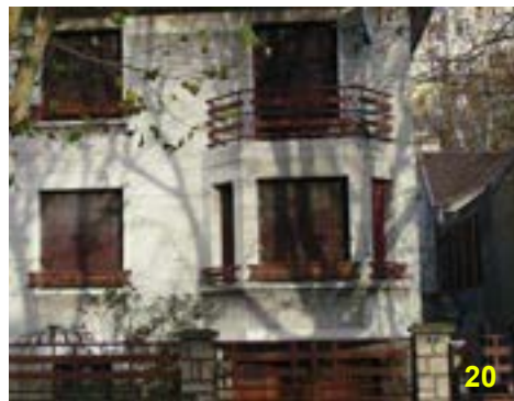
Les garde-corps et la clôture présentent le même dessin et forment ainsi un ensemble cohérent qui mérite d'être préservé.
