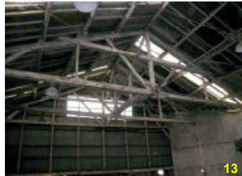
Ateliers Ribier Charpente bois
