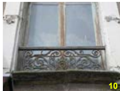
Exemples de menuiseries à petits bois et garde-corps du 18 ème siècle, âge florissant pour la ferronnerie.
