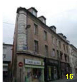
Au croisement de la rue du Jambon et de la rue Gabriel Péri, le petit pan coupé est traité avec des refends.
