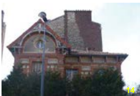
1 rue Désiré Lelay Pignon ouvragé présentant des éléments de charpente soignés et diversité des matériaux qui animent la façade
