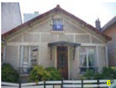
22 villa Anatole France Faux-colombage, marquise, garde-corps, porte d'entrée, tuiles de rive montrent qu'une grande attention a été portée aux détails.
