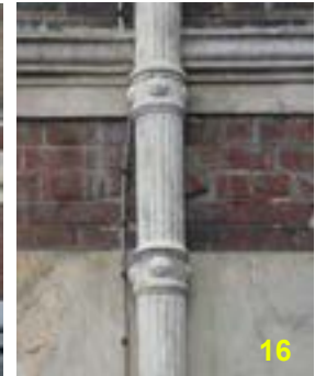
Descente d'eaux pluviales en fonte cannelée
