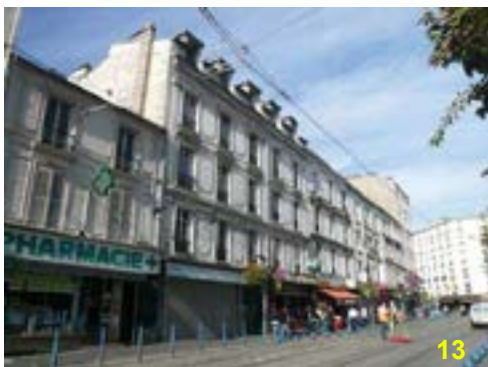
Rue Auguste Delaune, les corniches et bandeaux participent à la cohérence du front bâti et, avec l'ensemble des décors encore en place, à la qualité du paysage urbain.
