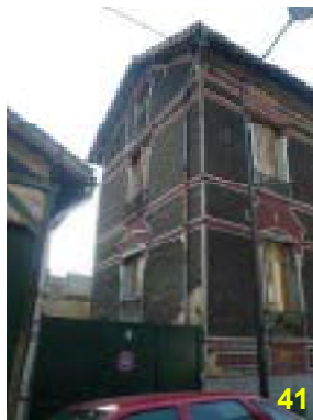
Logement du directeur au 8 rue Roussel
