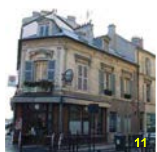
Couverture en zinc ayant très certainement remplacé le matériau d'origine
