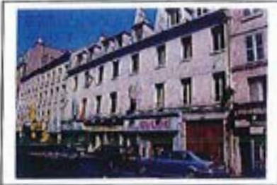
Façade sur rue Gabriel Péri du bâtiment A © Michéïl Wyss - UASD
