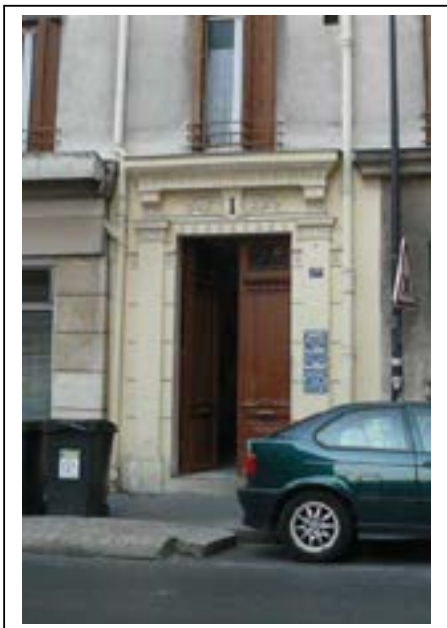
Détail de la porte et de son encadrement au n°1 ter : se sont les rares éléments de second œuvre conservés sur les façades de cet immeuble. Département de la Seine-Saint-Denis, DCPSL, SPC
