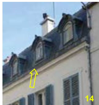
Chéneau posé sur corniche
