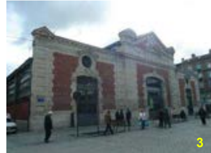
Façade principale de la halle du marché. L'emploi de la pierre sur cette seule façade marque l'entrée principale.
