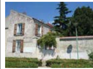
13 quai du Port Département de la Seine-Saint-Denis, DCPSL, SPC
