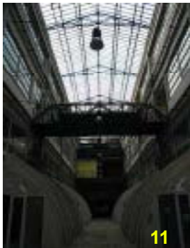
ZAC Montjoie Charpente métallique
