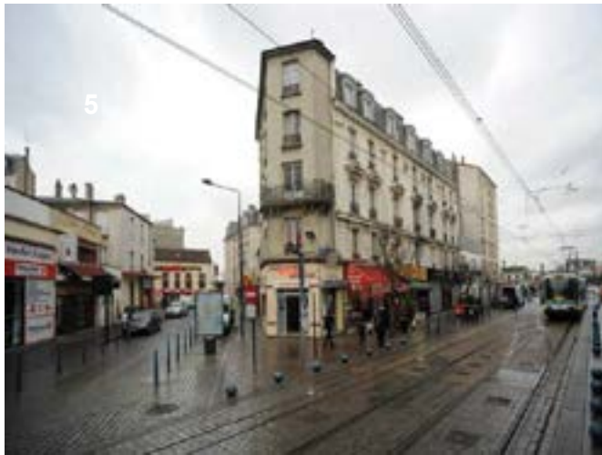
La structure de l'angle sud-ouest des rues Dezobry et Auguste Delaune © Jacques MANGIN - UASD - Département de la Seine-Saint-Denis
