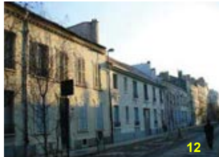
1 à 9 rue de la légion d'honneur Façades enduites
