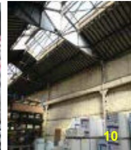
Usine Ribier Eclairage zénithal, latéral ou central, par sheds ou lanterneau
