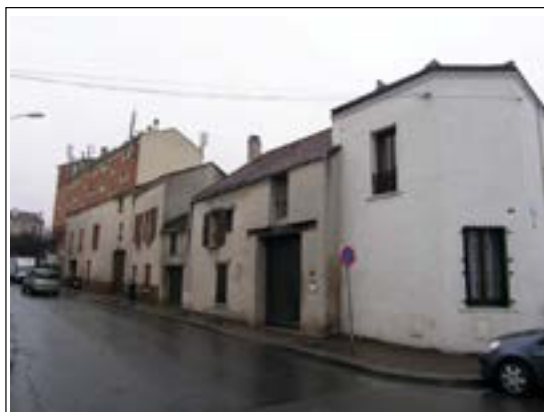
1 - Front partiel des numéros 6 à 12 rue Jollois. Les anciens portails cochers avec grand linteau bois et les allèges basses des baies du RDC témoignent de la typologie rurale
