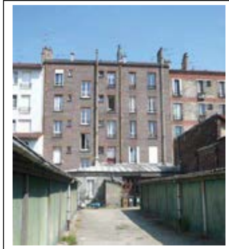
ci-contre : façade secondaire du 17 rue Dezobry Département de la Seine-Saint-Denis, DCPSL, SPC
