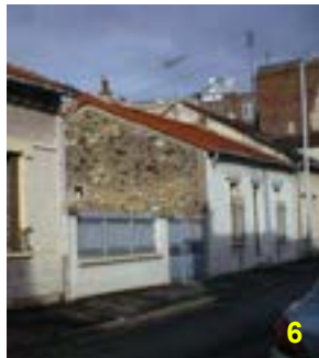
Couverture à deux pentes à 30° en tuiles mécaniques rue d'Arnouville
