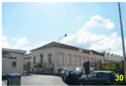
Ensemble administratif, construit en 1916, de l'ancienne usine Hotchkiss rue de Tunis
