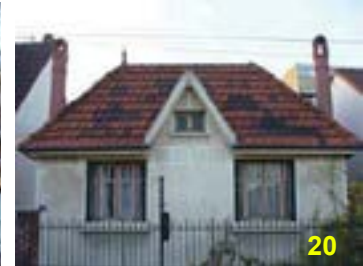
Symétrie affirmée avec ces deux cheminées graciles en briques de part et d'autre du toit à croupes
