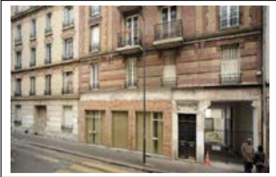
Détail du pied d'immeuble au n°17 © Jacques MANGIN - UASD - Département de la Seine-Saint-Denis
