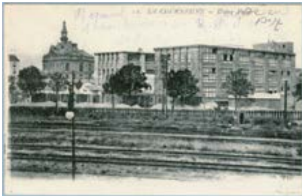
Vue du site de Johnson depuis les voies ferrées
