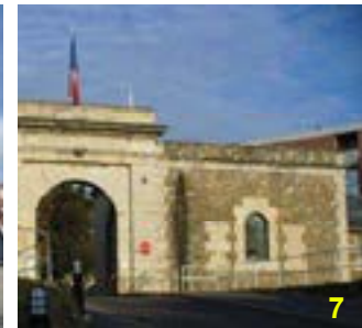
Pierre de taille pour les encadrements de baies et moellons équarris de meulière pour l'ensemble du mur
