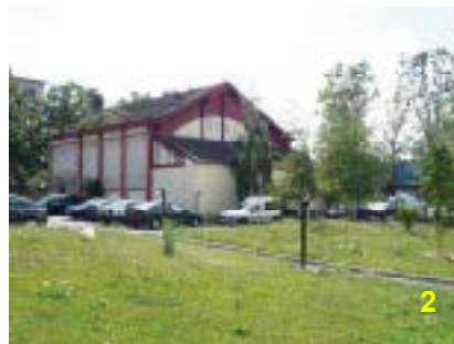
50 rue Charles Michel Salle des machines à vapeur de la mégisserie Combes
