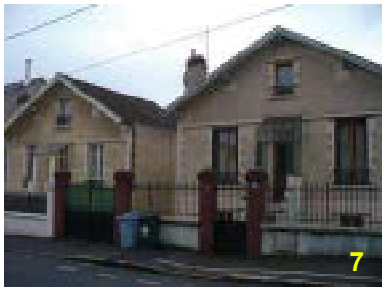
18 et 20 rue Ferrer Deux maisons individuelles en ensemble.
