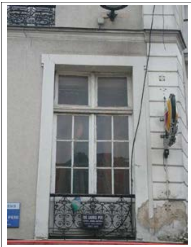
Détail d'une des baies flanquant le pan coupé du « Pavillon royal » : les huisseries anciennes, leurs rapports entre clairs de vitrage et petits bois, sont essentiels à la qualité de l'architecture. On notera le détail, sous les sommiers, de petits motifs de lambrequins. Département de la Seine-Saint-Denis, DCPSL, SPC
