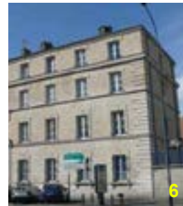
Appareil régulier et allongé marqué aux angles par une chaîne d'angle harpée à double hauteur d'assise
