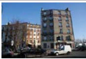
Façades des immeubles visibles depuis l'espace public. © Jacques MANGIN – UASD – Département de la Seine-Saint-Denis
