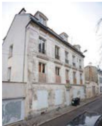
Façade principale et mur pignon nord © Jacques MANGIN – UASD – Département de la Seine-Saint-Denis
