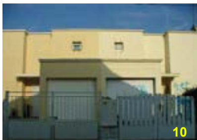
10 Lotissement Lurçat, rue Croxo Les ravalements effectués, de teintes différentes, et les portails remplacés nuisent à la logique d'ensemble.
