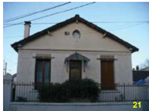
La marquise qui protège l'entrée est aussi un élément décoratif qui habille la façade et présente un intérêt patrimonial.
