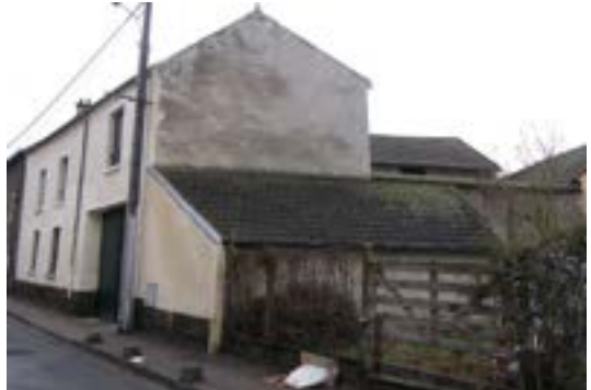
2 - Ancienne ferme du 11 rue de l'Abreuvoir
