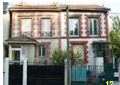
12 23 et 25 rue de la vieille Mer Les porches devant les maisons nuisent au principe de symétrie.
