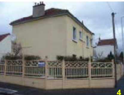
Angle rue Ferrer et rue Pasteur
