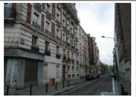
Détail de la façade rue Nicolas Leblanc où l'on voit la différence, au RDC, entre les travées ayant conservé leur décor et celles « lissées » à droite de la devanture.
