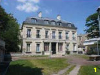
Emploi courant pour les bâtiments publics et administratifs, ici l'ancienne sous-préfecture
