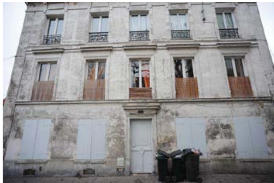
Détail de la façade © Jacques MANGIN - UASD - Département de la Seine-Saint-Denis
