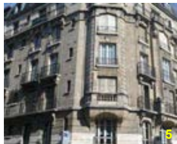
Hauteur d'assise homogène sur l'ensemble de la façade
