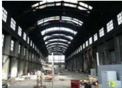
Entrepôt de la SNCF Charpente béton
