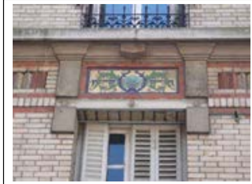
ci-dessus et ci-contre : 15 rue Dezobry, détail de la porte cochère et de ses chasse-roues, détail du couronnement des baies à R+1 Département de la Seine-Saint-Denis, DCPSL, SPC
