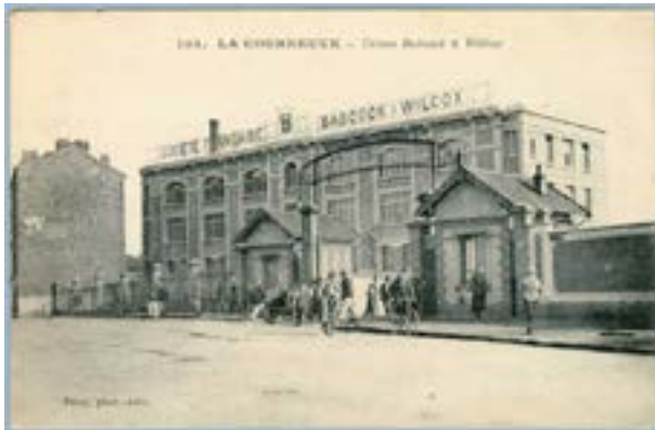
Vue de l'entrée principale et du bâtiment administratif
