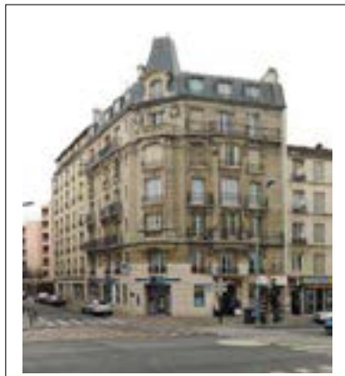
Façades sur rue © Jacques MANGIN – UASD – Département de la Seine-Saint-Denis
