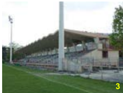
Tribunes du stade Auguste Delaune A. Lurçat (architecte)
