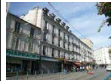
L'ensemble depuis le boulevard Jules Guesde Département de la Seine-Saint-Denis – DCPSL - SPC
