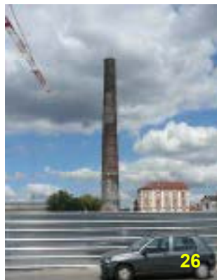
26 Cheminée d'usine intégrée aujourd'hui au nouveau groupe scolaire Cristino Garcia situé 6 rue du Landy
