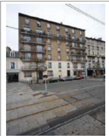
22, 22 bis, boulevard Carnot © Jacques MANGIN - UASD - Département de la Seine-Saint-Denis
