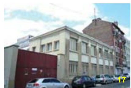
THT, usine d'électro-mécanique, rue Charles Michel
