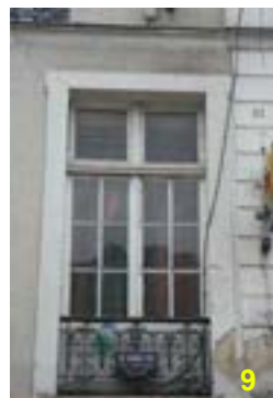
Exemples de menuiseries à petits bois et garde-corps du 18 ème siècle, âge florissant pour la ferronnerie.
