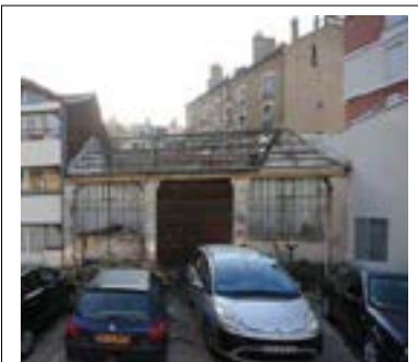
Vue de la chaufferie C depuis la cour. © Jacques MANGIN – UASD - Département de la Seine-Saint-Denis.
