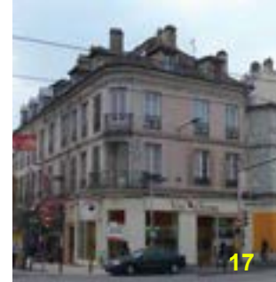
A l'angle de la rue Gabriel Péri au 127, l'angle arrondi libère le passage des carrosses. Les baies sont encadrées de refends sur toute la hauteur de la façade.
