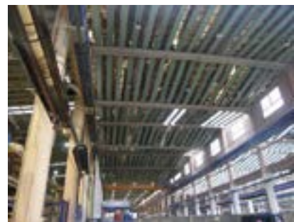
Halle en béton armé d'Alstom
