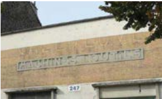
Si les lettres du nom de l'entreprise « Cazeneuve » ont été déposées, le bandeau en bas-relief dans lequel on peut lire « Machines-outils » rappelle la fonction du site.
