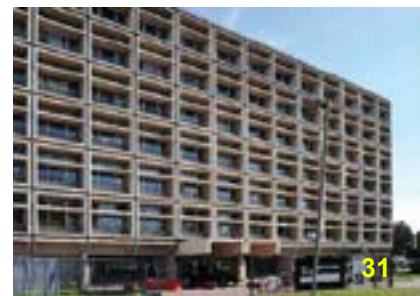
Bâtiment administratif de l'entreprise Alsthom Atlantique
