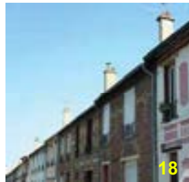
Rythme régulier des cheminées pour les maisons du coin du feu
