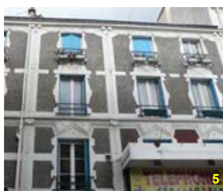
Enduit ciment et mignonette lavée au 113 rue Gabriel Péri
