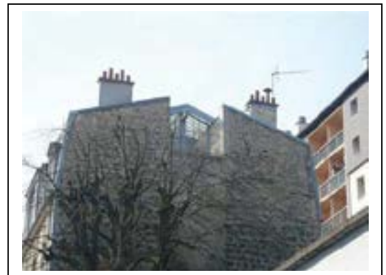
Détail du mur pignon Nord visible depuis l'espace public.
