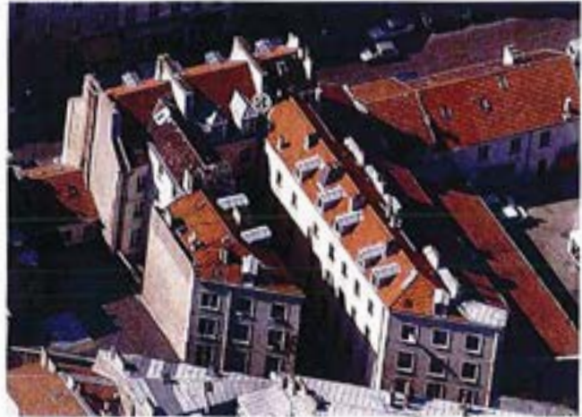
Vue aérienne oblique qui montre la quasi symétrie des deux ailes secondaires et l'utilité, pour l'éclairage de l'aile principale, du décroché du corps Est de l'aile Sud (flèche). A - Octobre 2009 © Habitat 2008
