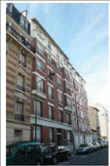
3 rue Nicolas Leblanc Département de la Seine-Saint-Denis, DCPSL, SPC
