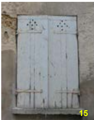
15 Volets pleins en bois avec trous d'aération en partie haute
