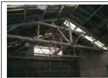
Charpente en bois de la halle. Département de la Seine-Saint-Denis
