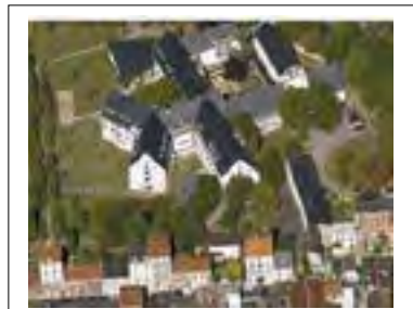
Vue oblique de la maison de retraite. IA – Oblique 2008 © InterAtlas 2009
