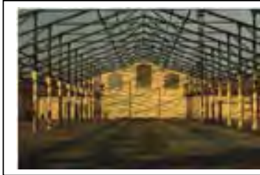
Ossature mise à nu pendant le chantier. Département de la Seine-Saint-Denis, DCPSL, SPC
