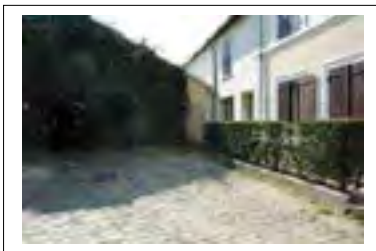
Façade sur cour du bâtiment D (en arrière plan) © Jacques MANGIN-UASD-Département de la Seine-Saint-Denis
