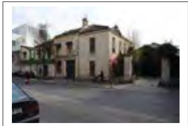
Façade sur rue Département de la Seine-Saint-Denis, DCPSL, SPC
