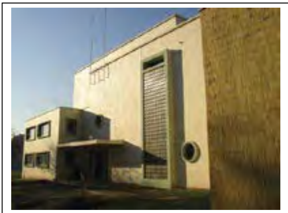
Avenue Sémat (façade est, entrée sud) Département de la Seine-Saint-Denis, DCPSL, SPC, N. Simonnot
