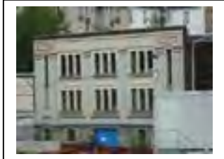
Façade sur rue Brise Echalas Département de la Seine-Saint-Denis, DCPSL, SPC
