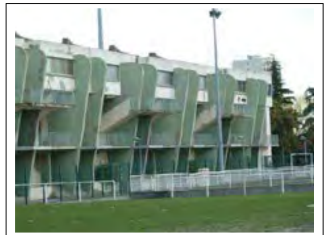
Détail de la façade arrière de la grande tribune Département de la Seine-Saint-Denis, DCPSL, SPC
