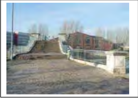
Escalier de la passerelle Thiers depuis le square (2012).
