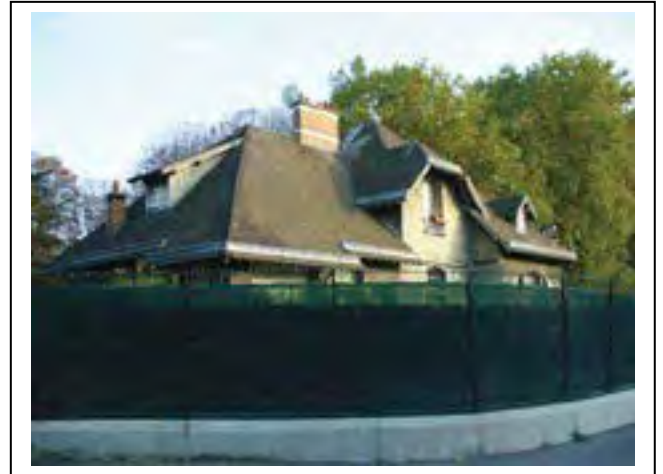
Ci-contre et ci-dessus : maison d'habitation : angle sud-est (à gauche), façade ouest (à droite) © Jacques Mangin - UASD - Département de la Seine-Saint-Denis Département de la Seine-Saint-Denis, DCPSL, SPC
