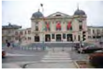
Façade sur le boulevard, ancienne école des garçons
