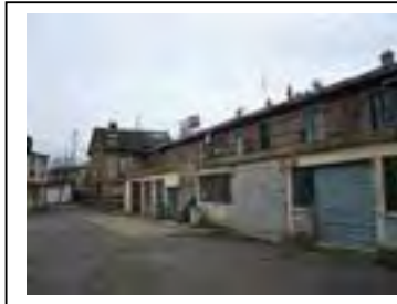
Vue des logements depuis la cour Département de la Seine-Saint-Denis ©
