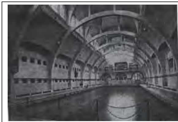
Ci-dessus : L'intérieur du bassin de la piscine de la Butte-aux-Cailles construite en 1924 à Paris par L. Bonnier. Architecture d'aujourd'hui , avril 1934, p.59
