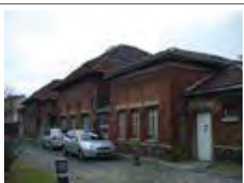
L'aile des services techniques composée d'une succession de sept pavillons articulés autour d'une aile centrale. Département de la Seine-Saint-Denis, DCPSL, SPC
