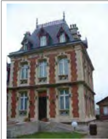
Façade sud, avant-corps formant pavillon Département de la Seine-Saint-Denis, DCPSL, SPC
