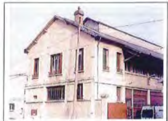
L'atelier des charpentes, lanterneau d'adrasion. Département de Seine-Saint-Denis, CCPLB, SPC
