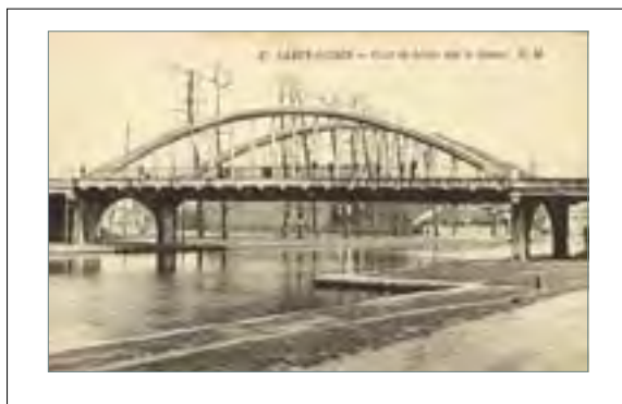
Pont Francis de Pressensé vers 1925
