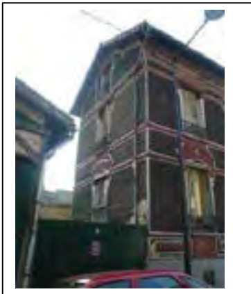
Pignon du pavillon. Département de la Seine-Saint-Denis, DCPSL, SPC
