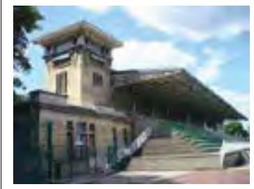
Façade est des tribunes de l'ancien hippodrome Département de la Seine-Saint-Denis, DCPSL, SPC
