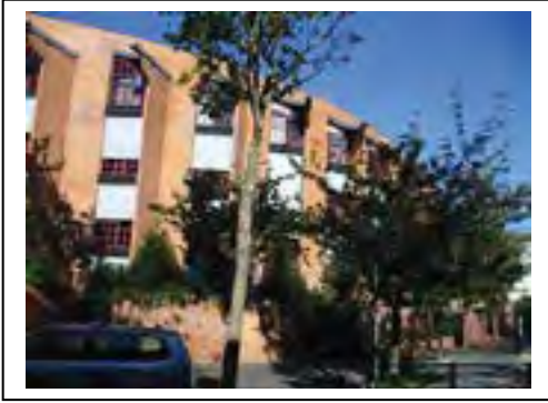
Les grandes travées qui animent la façade principale, rue P. Eluard.
