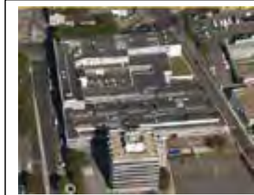
Vue oblique de la parcelle, au premier plan l'immeuble de bureaux et au second les anciens ateliers Rachline. IA Oblique 2008 © InterAtlas 2009
