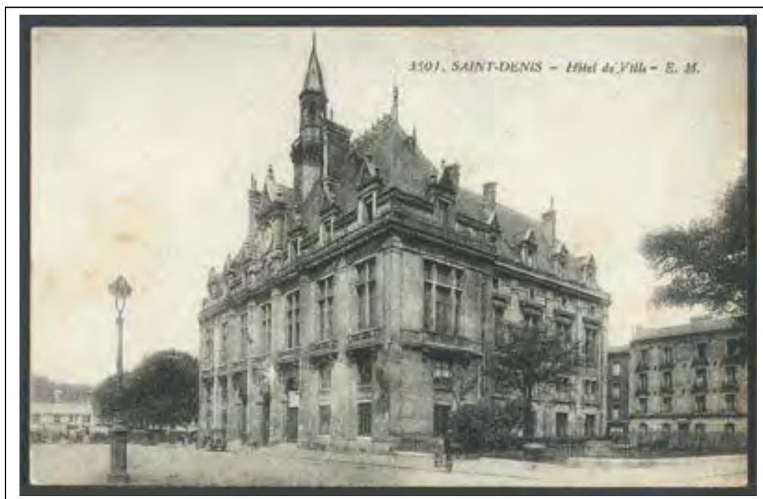
AD93, 2 Fi Saint-Denis 614, carte postale s.d. : la façade latérale nord.
