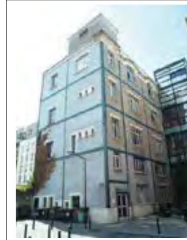
Façade sur cour, vue de la machinerie du monte charge. Département de la Seine-Saint-Denis, DCPSL, SPC
