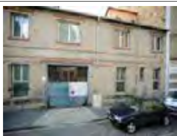
Façade sur rue Paul Nay Département de la Seine-Saint-Denis, DCPSL, SPC
