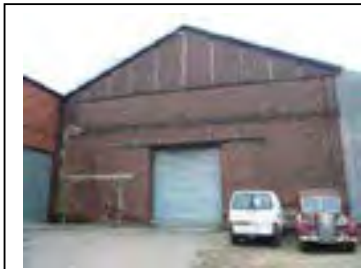
Pignon de la halle de stockage Département de la Seine-Saint-Denis
