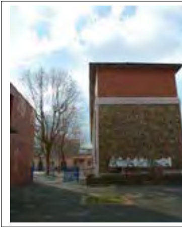
En haut : façade rue Simon En bas : mur latéral depuis la rue Leroy des Barres avec au fond à l'arrière l'extension réalisée dans les années 1930. Département de la Seine-Saint-Denis, DCPSL, SPC
