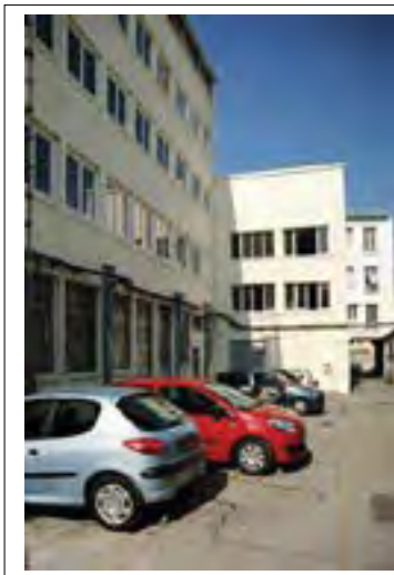
Façade sur cour des bâtiments E et F Département de la Seine-Saint-Denis, DCPSL, SPC
