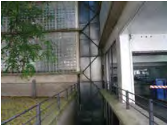
La jonction entre les deux bâtiments par la grande verrière verticale et la sortie du garage. Département de la Seine-Saint-Denis, DCPSL, SPC
