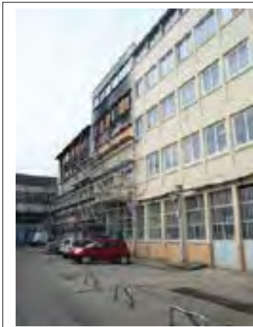
Façade sur cour des ateliers C et D depuis la cour. Département de la Seine-Saint-Denis, DCPSL, SPC
