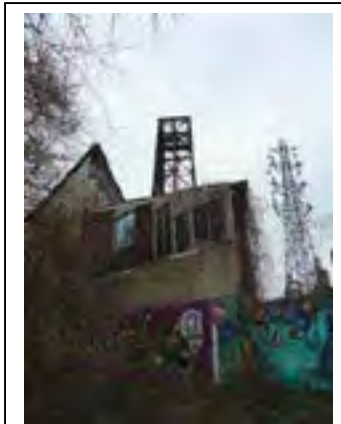
Vue de la structure métallique du casse-fonte. Ménagement de la Seine-Saint-Denis
