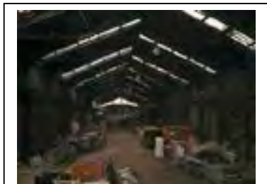
Intérieur de la halle, vue des fermes métalliques Département de la Seine-Saint-Denis
