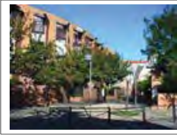
Façade sur rue Département de la Seine-Saint-Denis, DCPSL, SPC
