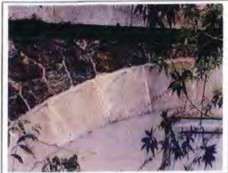
Détail des pierres de l'arche portant les traces caractéristiques de la boucharde. © Michel Wael - 0430
