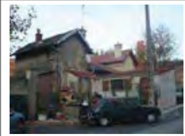
Façade arrière (sud) sur le chemin d'accès à la cité.
