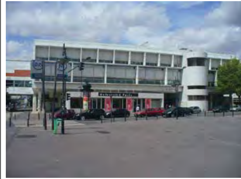
Façade est avec à droite l'escalier hors oeuvre Département de la Seine-Saint-Denis, DCPSL, SPC
