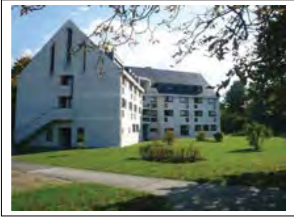
L'aile ouest du bâtiment, au troisième étage on devine une salle de prière destinée aux soeurs.
