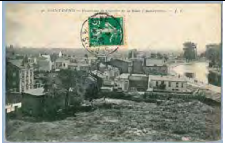
Vue du Bel Air vers 1910 à hauteur du 66-72, rue Danielle Casanova.
