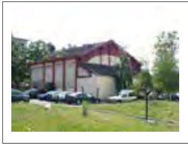
Façade Est et pignon Nord donnant sur la rue Charles Michel, 2010
