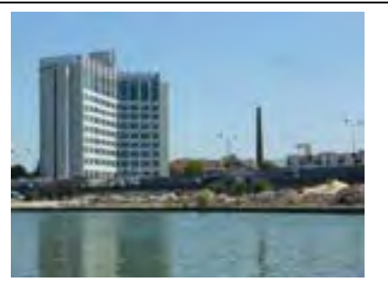
Perspective sur la cheminée depuis le bassin.
