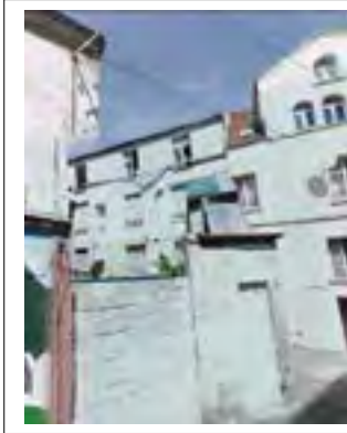
Façade sur rue Département de la Seine-Saint-Denis, DCPSL, SPC
