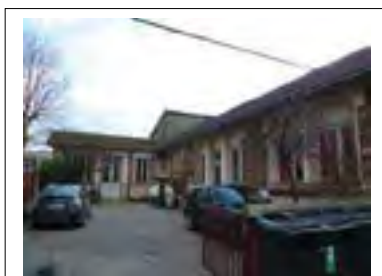
Deux bâtiments du Centre médico psycho-pédagogique : à droite, l'ancienne école maternelle et en fond de cour, un petit bâtiment qui est une extension ancienne aujourd'hui rattachée au centre. Département de la Seine-Saint-Denis, DCPSL, SPC
