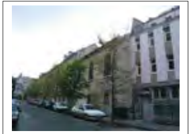
Façade sur rue Département de la Seine-Saint-Denis, DCPSL, SPC
