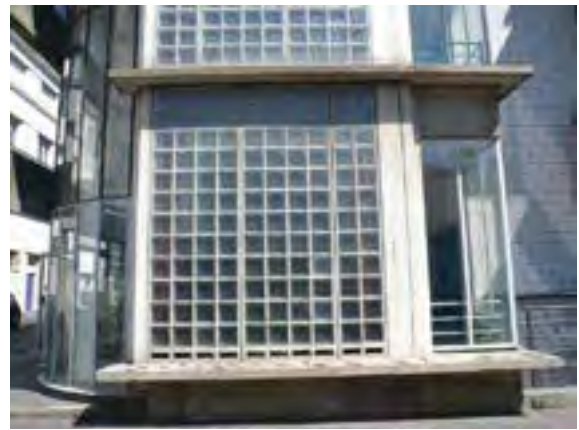
Détail du panneau de briques de verre. Département de la Seine-Saint-Denis, DCPSL, SPC
