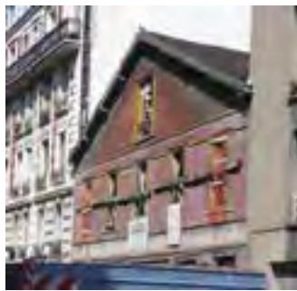
Façade sur rue Département de la Seine-Saint-Denis, DCPSL, SPC
