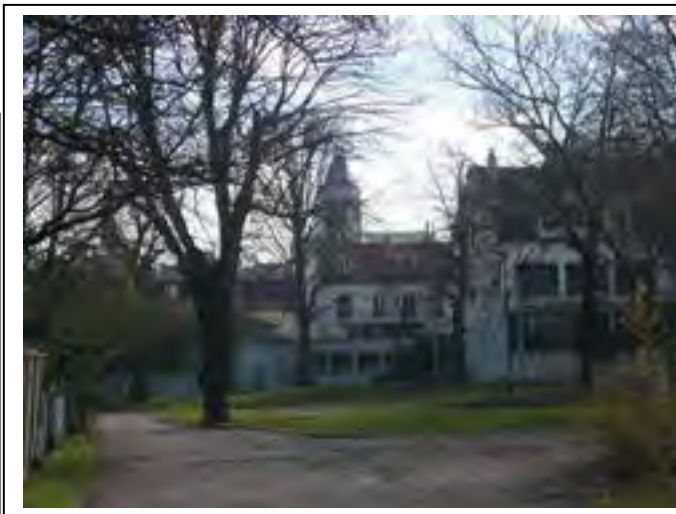
Ci-contre à gauche : début 2010 vue de la façade postérieure du bâtiment de la Poste depuis la friche de l'ancienne salle de spectacles « Saint-Denis kermesse ». Département de la Seine-Saint-Denis, DCPSL, SPC
