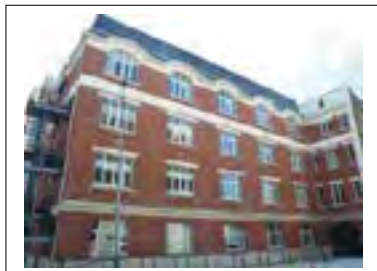
Façade nord. Département de la Seine-Saint-Denis, DCPSL, SPC
