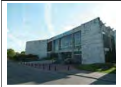
Piscine interdépartementale de Marville (E) Façade est (entrée) Département de la Seine-Saint-Denis, DCPSL, SPC
