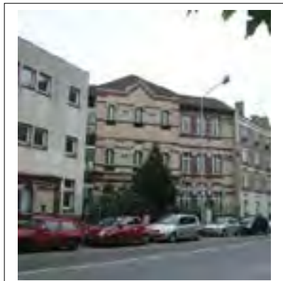
Façade boulevard de la Libération. Département de la Seine-Saint-Denis, DCPSL, SPC
