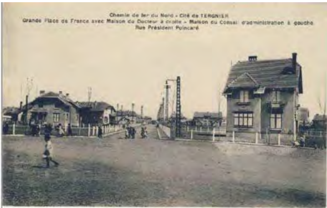
Cité cheminote de Tergnier. Exemple d'architecture néo-régionaliste réalisée par la Cie de chemin de fer du Nord et dont s'inspire le pavillon double de la gare de marchandises. Coll. part.
