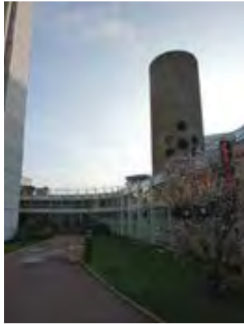
Vue de la façade des locaux sous dalle et du dispositif d'aération. Département de la Seine-Saint-Denis, DCPSL, SPC
