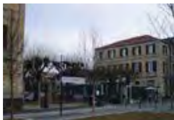
Grille et porte d'entrée de l'hôpital Département de la Seine-Saint-Denis, DCPSL, SPC
