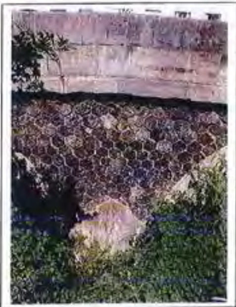
Vue de la maçonnerie en pierre de meulière, du parapet et du chaperon de l'arrière-bec en pierre calcaire. © Michel Wael - 0430
