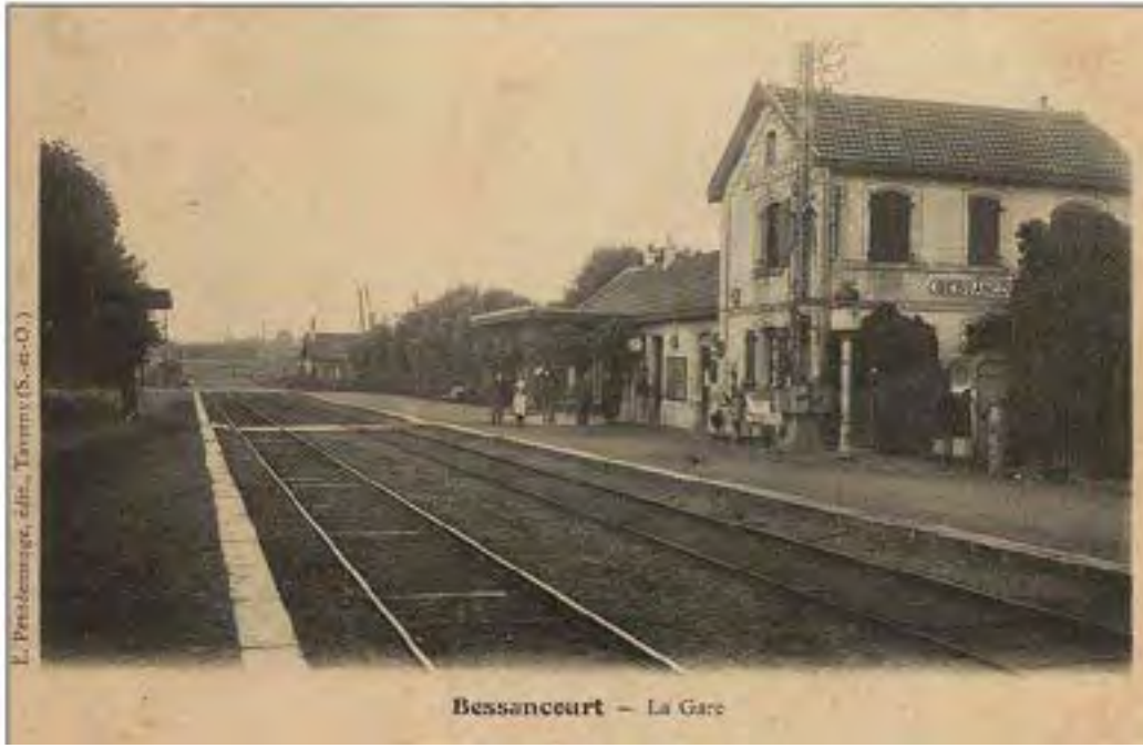
Gare de Bessancourt, modèle standard de la Cie de chemin de fer du Nord dont le plan est repris pour la construction du petit logement de cheminot de la gare de marchandises. Coll. part.
