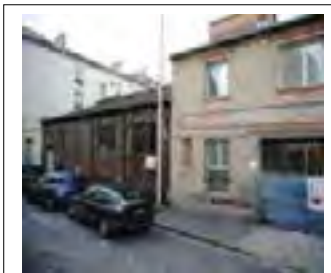
Façade sur rue Paul Nay Département de la Seine-Saint-Denis, DCPSL, SPC
