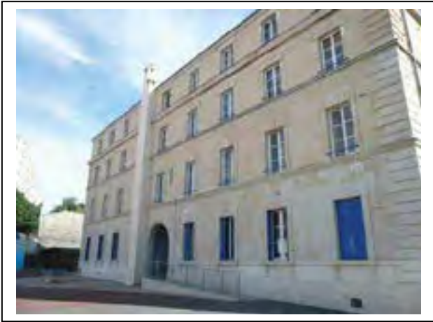
La façade postérieure et le mur de pignon sud. Détail de la continuité des éléments de modénature et de décors, sur l'ensemble des façades. Département de la Seine-Saint-Denis, DCPSL, SPC
