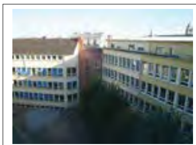
Façade du bâtiment 9 rue des Ursulines (en haut) et façades du bâtiment sur la cour (en bas). H1 Département de la Seine-Saint-Denis, DCPSL, SPC
