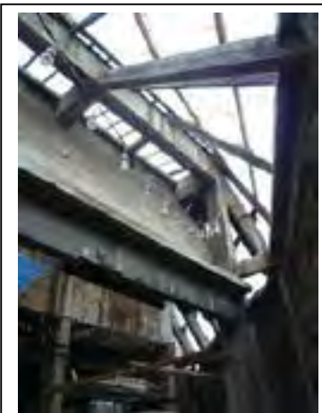
Structure en béton armé et éclairage de l'atelier du casse-fonte. Département de la Seine-Saint-Denis
