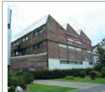
Façade sur l'avenue du Stade de France Département de la Seine-Saint-Denis, DCPSL, SPC
