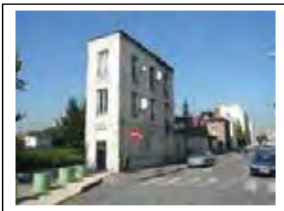
Façade sur rue du bâtiment A Département de la Seine-Saint-Denis, DCPSL, SFC
