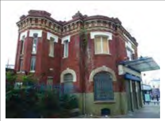
Le pignon nord-est, la cage d'escalier et les imposants décors formant frise.
