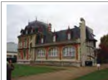
Façade nord Jacques MANGIN – UASD – Département de la Seine-Saint-Denis
