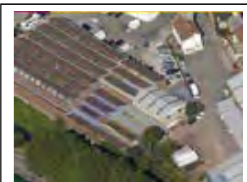
Vue générale des magasins. IA Obliques 2008 © InterAtlas 2009
