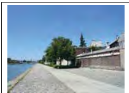
Les berges à la hauteur des ateliers cad AJ / 5.
