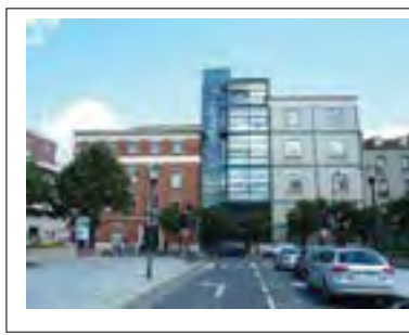
Vue de la jonction de l'ensemble bureaux-magasins et de depuis l'avenue Département de la Seine-Saint-Denis, DCPSL, SPC
