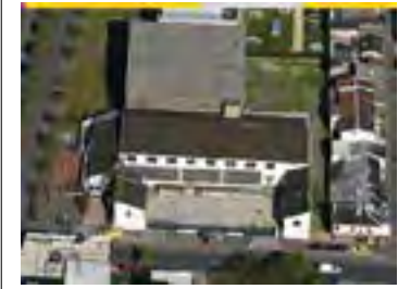
Vue du site IA Obliques 2008 © InterAtlas 2009
