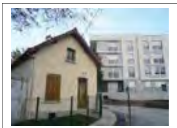
Façade ouest, chemin d'accès à la cité Département de la Seine-Saint-Denis, DCPSL, SPC
