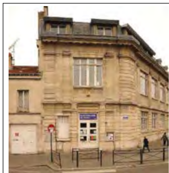
L'entrée latérale ouest en retour rue Suger, entrée actuelle de l'école maternelle. © Jacques MANGIN – UASD - Département de la Seine-Saint-Denis
