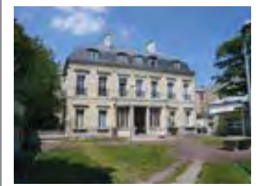
Façade Sud de l'ancienne sous-préfecture Département de la Seine-Saint-Denis, DCPSTL, SPC
