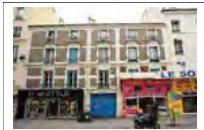
Façade sur rue Département de la Seine-Saint-Denis, DCPSL, SPC
