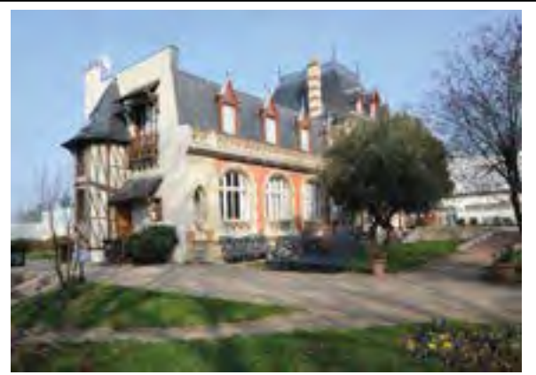
Façade sud et ouest du bâtiment principal Jacques MANGIN - UASD - Département de la Seine-Saint-Denis
