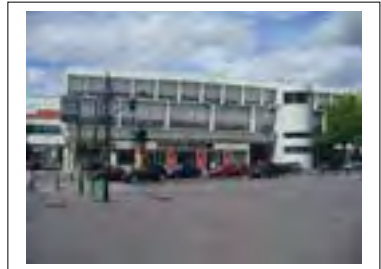
Façade depuis le parvis du métro Département de la Seine-Saint-Denis, DCPSL, SPC
