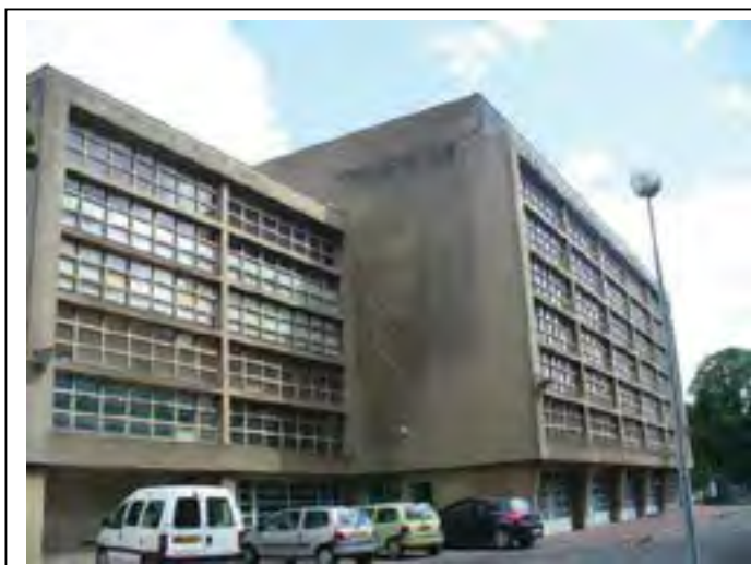
Ci-contre et ci-dessus : façade ouest des tribunes de l'ancien hippodrome. Une importante extension a été réalisée et le bâtiment bas situé initialement au pied de la tourelle a été supprimé. Département de la Seine-Saint-Denis, DCPSL, SPC
