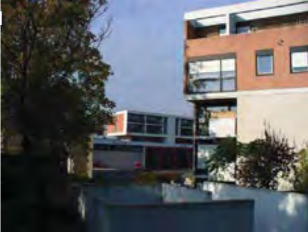
Les terrasses plantées de l'ensemble de logements familiaux, côté cour central. Département de la Seine-Saint-Denis, DCPSL, SPC
