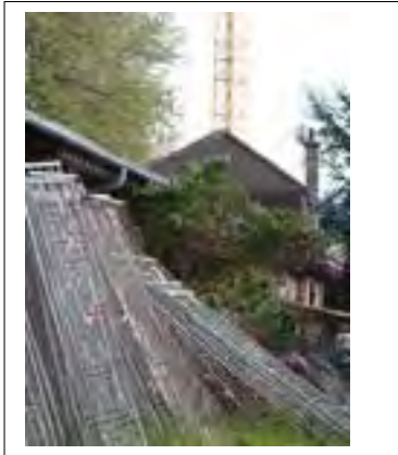
Au 2 nd plan : pavillon sud des anciennes écuries (D1). On aperçoit que la pente de la toiture a été modifiée
