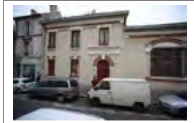
Façade du pavillon d'entrée sur rue Département de la Seine-Saint-Denis, DCPSL, SPC
