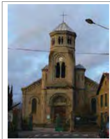
Façade principale Département de la Seine-Saint-Denis, DCPSL, SPC
