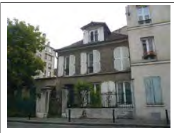
La maison du 12 rue des Chaumettes implantée sur la même parcelle Département de la Seine-Saint-Denis, DCPSL, SPC
