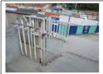
Rambarde métallique encadrement l'emmarchement situé devant l'entrée du palais des sports Département de la Seine-Saint-Denis, DCPSL, SPC
