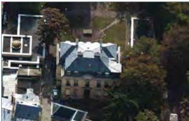
Ci-contre à gauche : vue aérienne oblique de la façade Nord de la Sous-préfecture et ci-dessous la même façade
