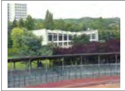
Piscine interdépartementale de Marville (E) Façade sud Département de la Seine-Saint-Denis, DCPSL, SPC
