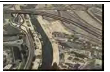
Vue du quartier en 1968, une partie a été amputée par l'aménagement de l'autoroute, cependant qu'il reste encore le dépôt d'hydrocarbures le long des berges du canal
