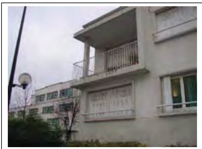
Détail d'un des immeubles de logements de fonction avec son balcon caractéristique.
