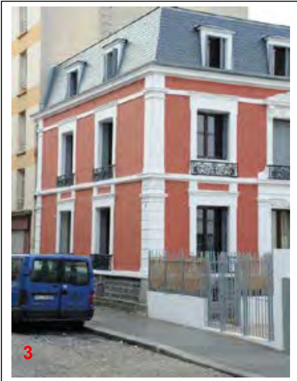
1-2 - Vue de la façade principale du pavillon avant restauration et après restauration. © Google earth © Jacques MANGIN – UASD - Département de la Seine-Saint-Denis 3- Vue de la façade sur rue. © Jacques MANGIN – UASD - Département de la Seine-Saint-Denis
