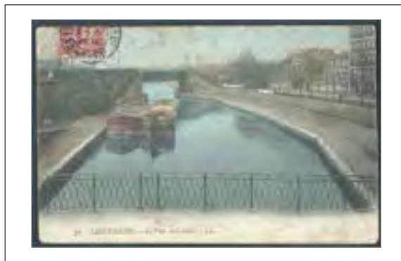
Pont ferroviaire depuis le pont de la rue du port, vers 1910
