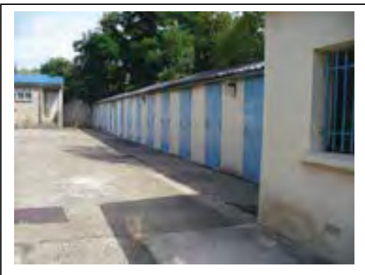
Ci-dessus : cabines avec au fond le groupe sanitaire et local annexe (premier plan) Ci contre : maison d'habitation du gardien Département de la Seine-Saint-Denis, DCPSL, SPC
