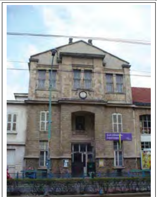
Pavillon latéral Ouest de l'école boulevard Félix Faure Département de la Seine-Saint-Denis, DCPSL, SPC
