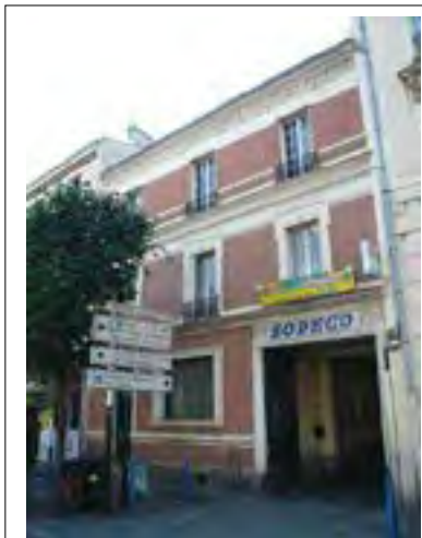
Façade sur rue Département de la Seine-Saint-Denis, DCPSL, SPC
