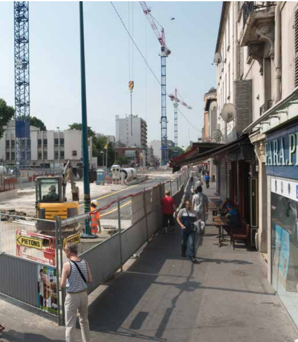
Travaux de prolongement de la Ligne 12 du métro à Aubervilliers.
